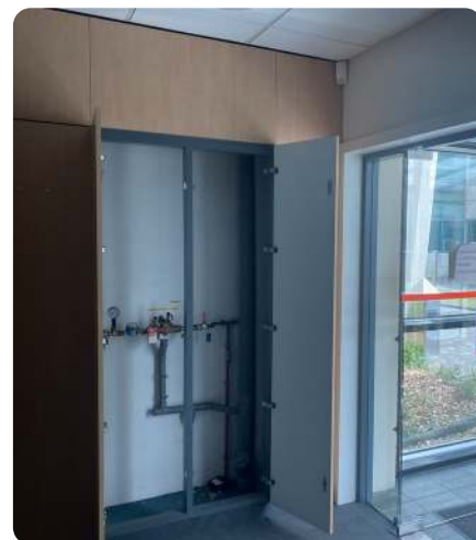
SITE OCCUPÉ & INTERFACES
